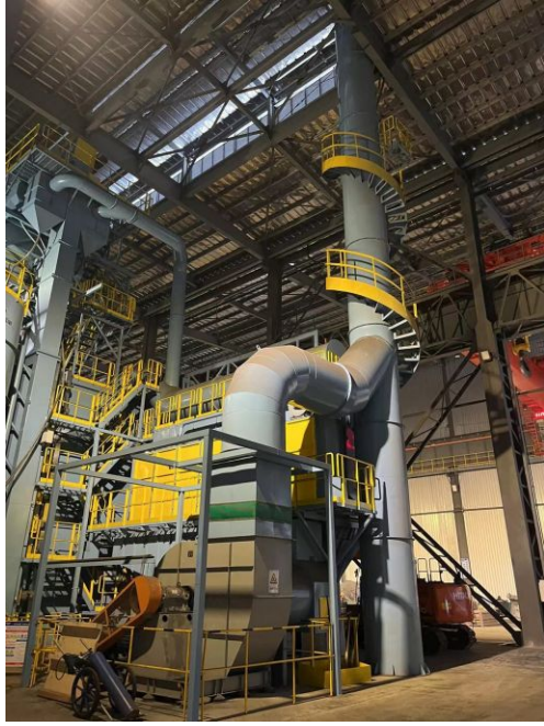
抛丸废气处理设施及排气筒
