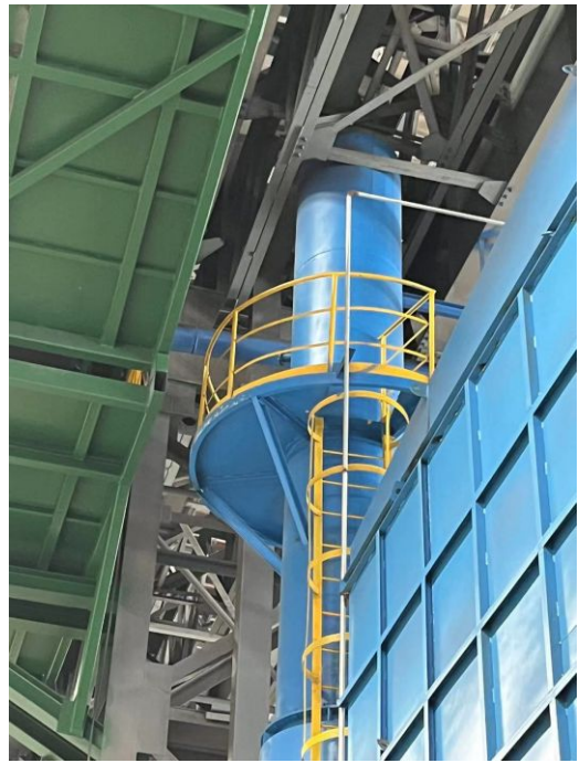
混砂废气处理设施及排气筒
