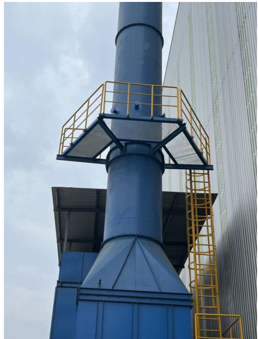
打磨废气处理设施及排气筒
