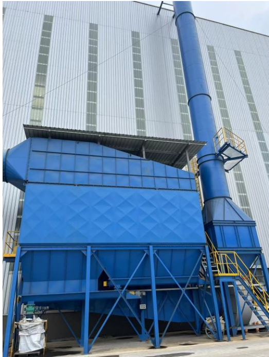
打磨废气处理设施及排气筒
