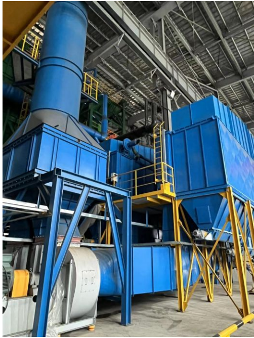
熔化废气处理设施及排气筒
