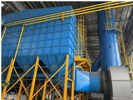
砂处理废气处理设施及排气筒
