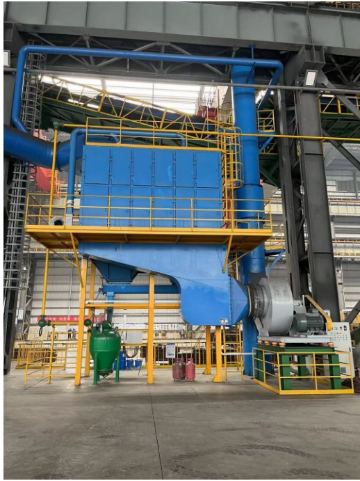
混砂废气处理设施及排气筒
