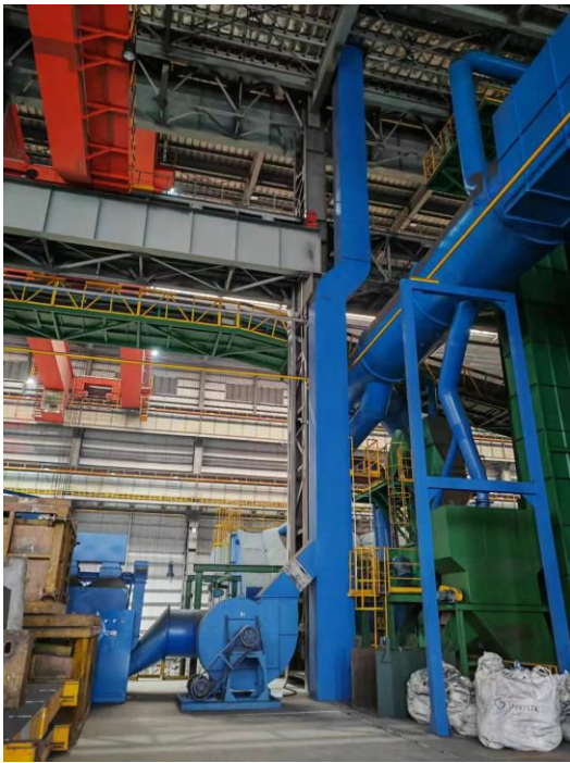
造型、浇注废气处理设施及排气筒
