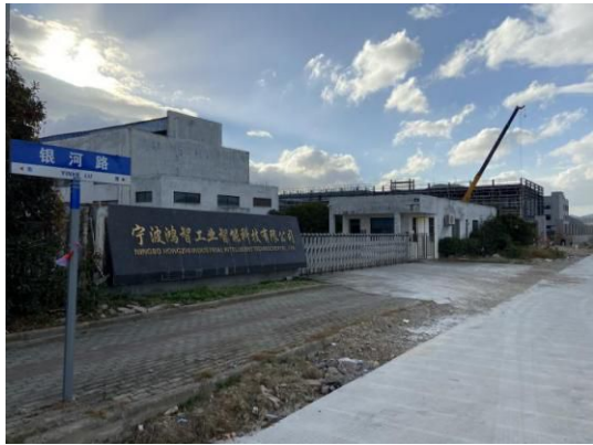
项目西侧鸿智工业
