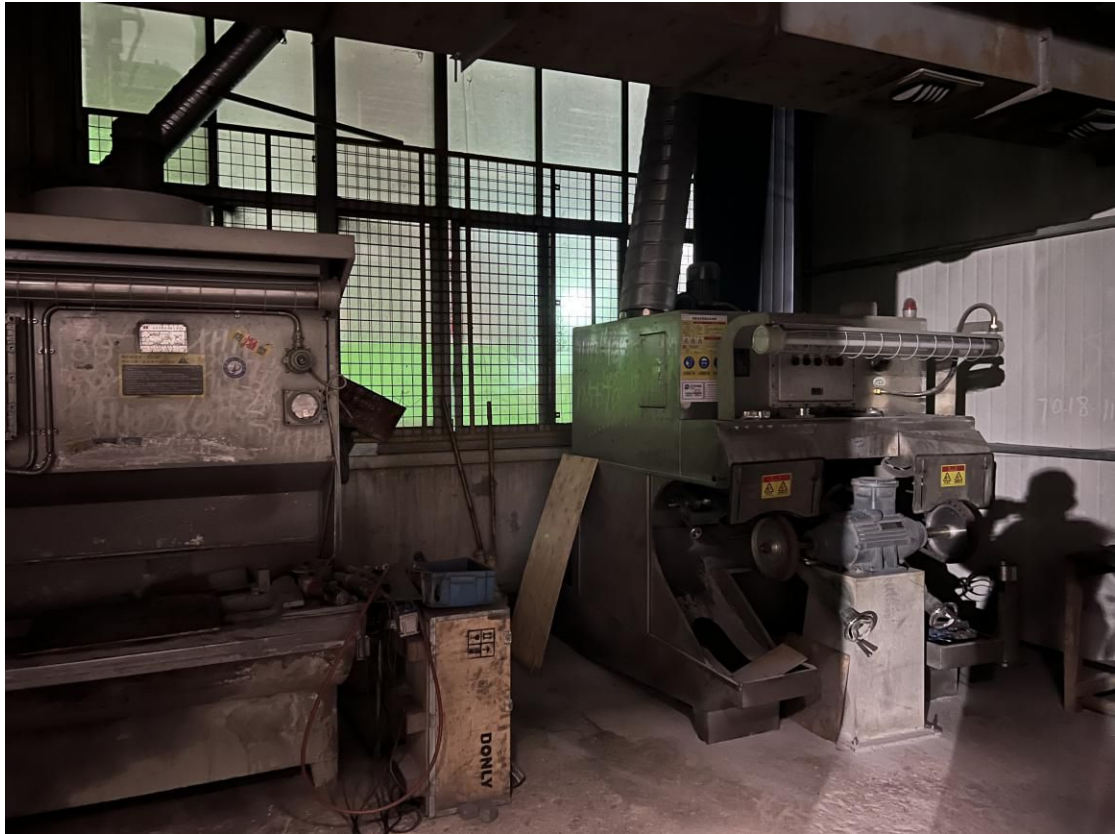
打磨废气处理设施
