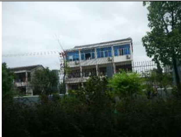
北侧：隔路为金联村居民点
