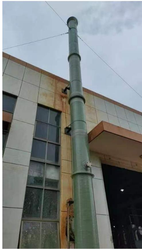
隧道窑烘干废气处理设施及排气筒
